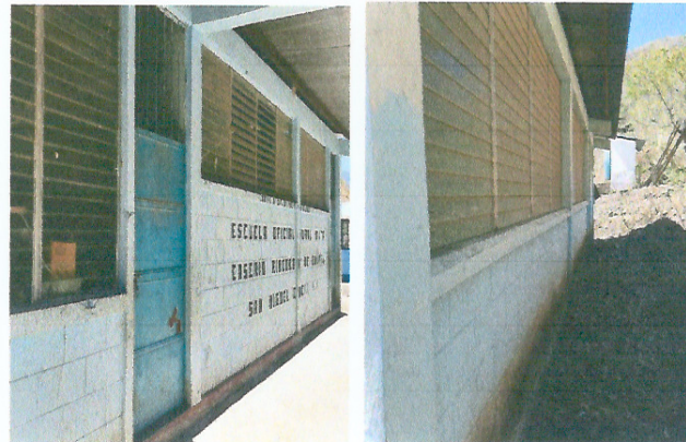
Foto 2: MEJORAMIENTO E INSTALACION DE BALCONES
